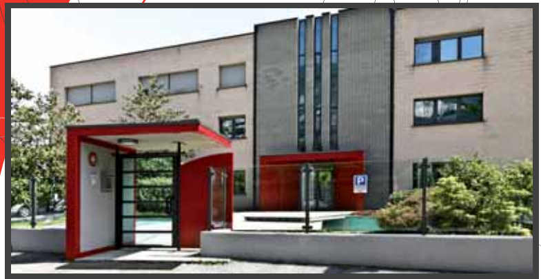
Sede produttiva | Plant | Produktionswerk
