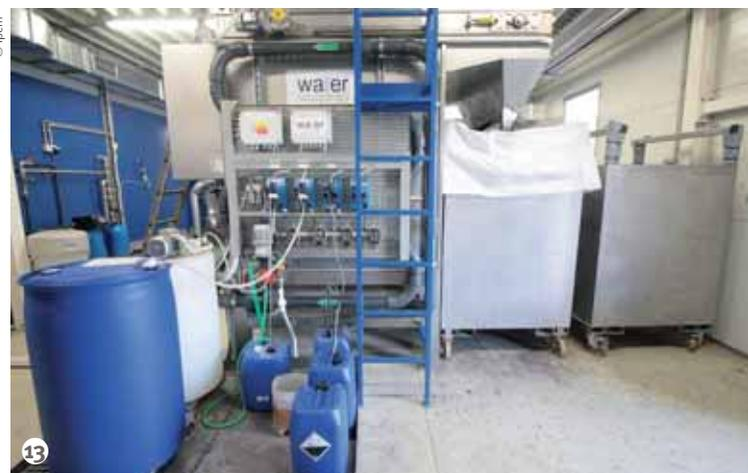
Figura 13: Il defangatore Skimmerflot di Water Energy con portata di 15000 litri/ora.
