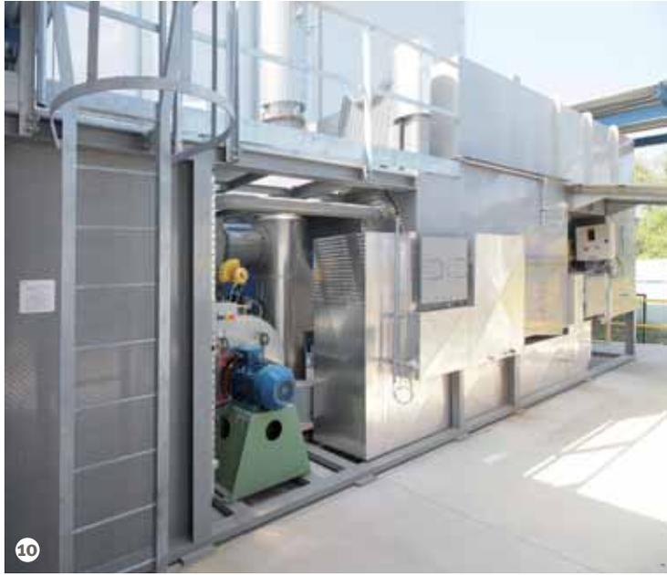
Figura 10: Il post-combustore termico rigenerativo (RTO) installato da Brofind.
