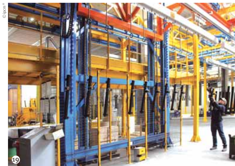
Figura 19: L'area di scarico.
