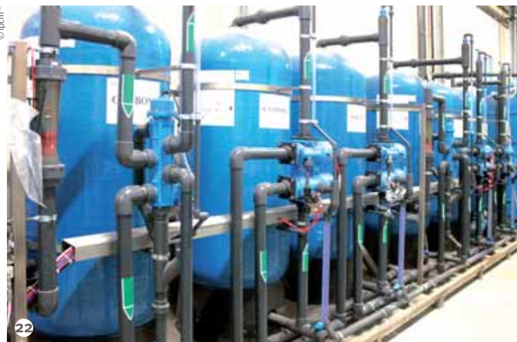
Figura 22: Il demineralizzatore installato da Water Energy.
