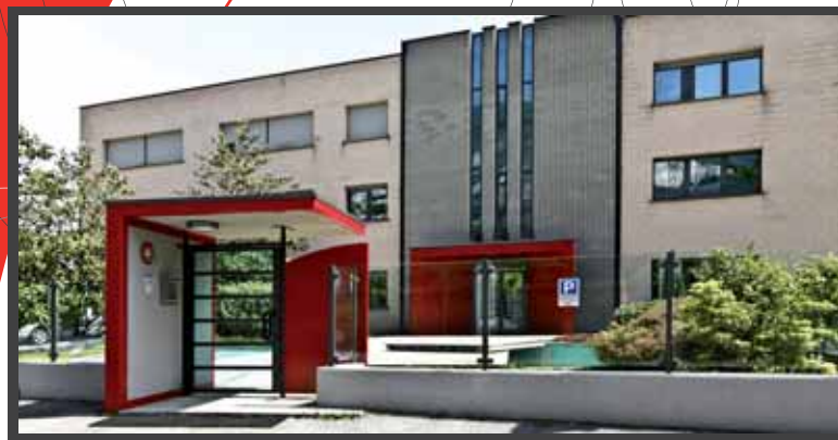
Planta de producción | Fábrica | Plant
